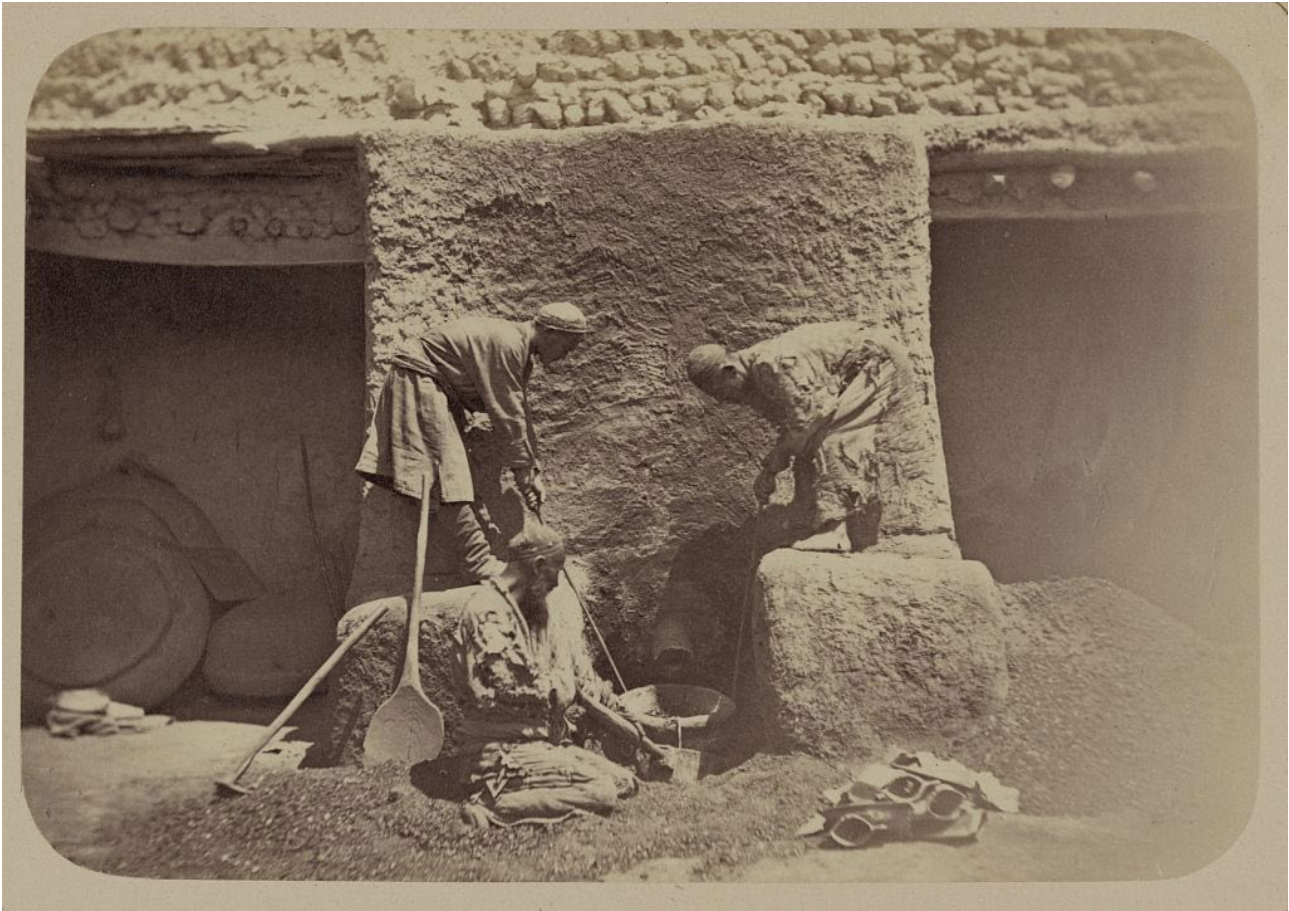
Илл. 3. Чугунно-литейное производство. Горн для плавки чугуна (даши-дигризи). Часть промысловая: у туземного населения в русских владениях Средней Азии, л. 14, № 68. Туркестанский альбом, по распоряжению туркестанского генерал-губернатора К.П. фон Кауфмана I-го составил А.Л. Кун. Ташкент, 1871–1872 гг. Библиотека Конгресса (США), отдел графики и фотографий.
