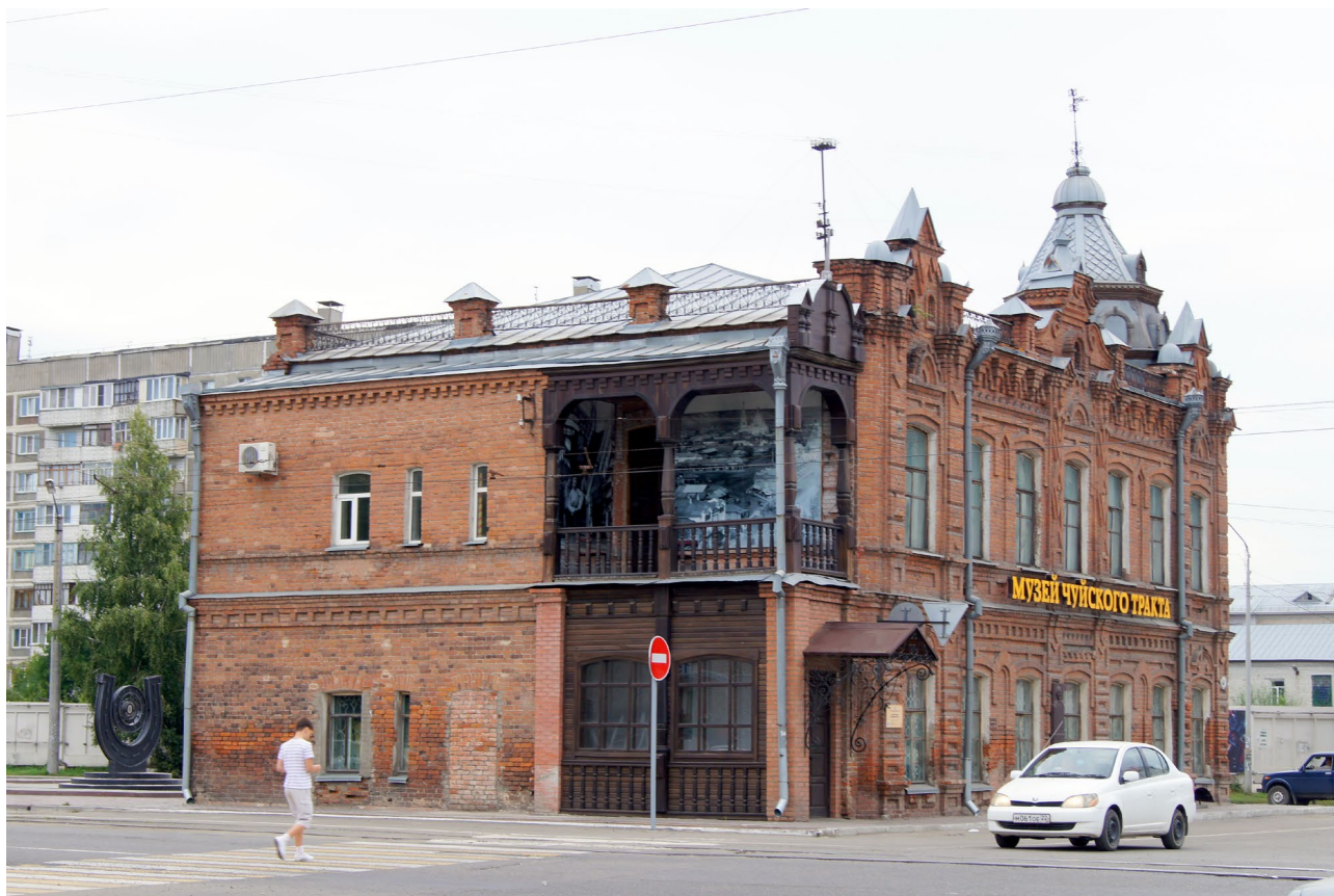
Ил. 4. Музей Чуйского тракта, г. Бийск, ул. Советская, 42. Юго-западный фасад. Фото 2014 г. [Из архива НПЦ «Наследие»]
