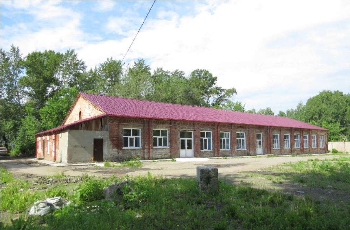
Ил. 3. Конюшня. Северо-восточный фасад. 2018 г. Снимок из архива ГАУ НСО НПЦ
