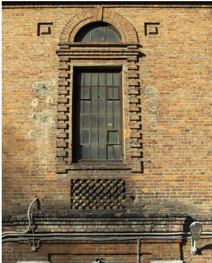
Ил. 4. Дом жилой. Общий вид на здание по ул. Тополевая, 4 с востока. 2018 г. Снимок из архива ГАУ НСО НПЦ
