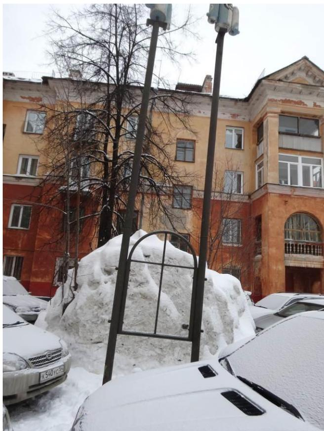
*Рис. 3. Деформация композиции из-за просадки грунта основания двора «Алиса». Фото авторов, 2019 г.*
