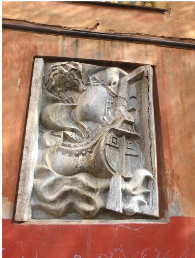
Рис. 6. Трещины в бетонном барельефе «Гулливвер». Фото авторов, 2018 г.
