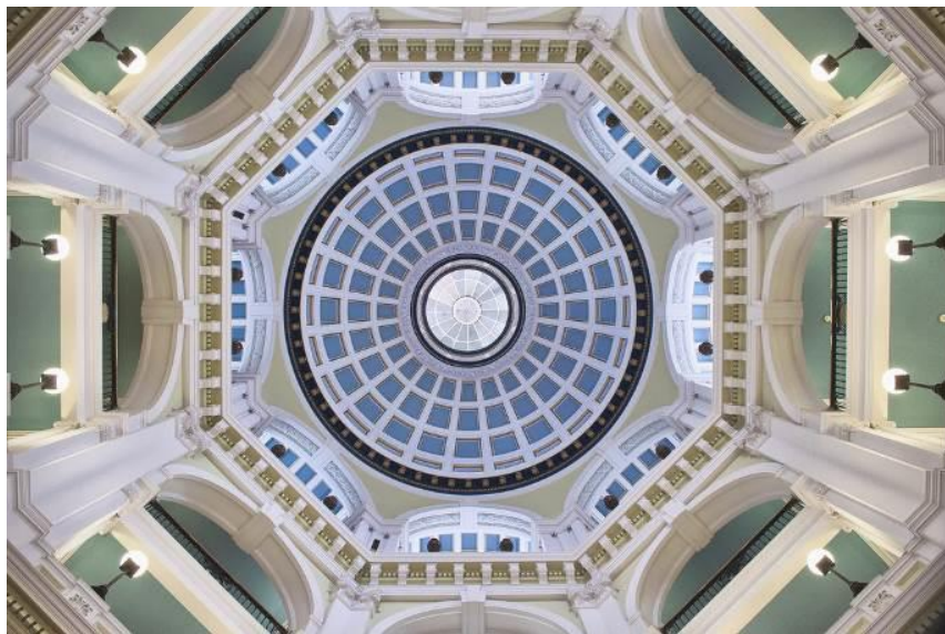
Рис. 1. Творчество сэра Арнольда Торнли. Здание Ливерпульского порта. 1907 г. (необарокко) [7]
